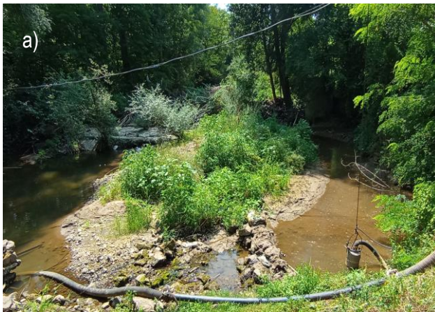
Slika 28. a) Postojeća način zahvatanja vode iz Jablanice direktno pompom b) postojeća pumpna stanica za potrebe flotacije rudnika Lece
