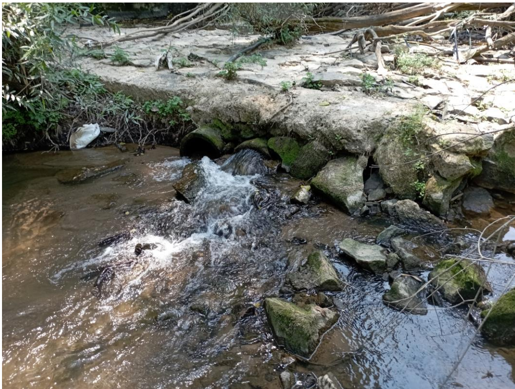
Slika 27. Postojeća brana na reci Jablanici za potrebe flotacije rudnika Lece
