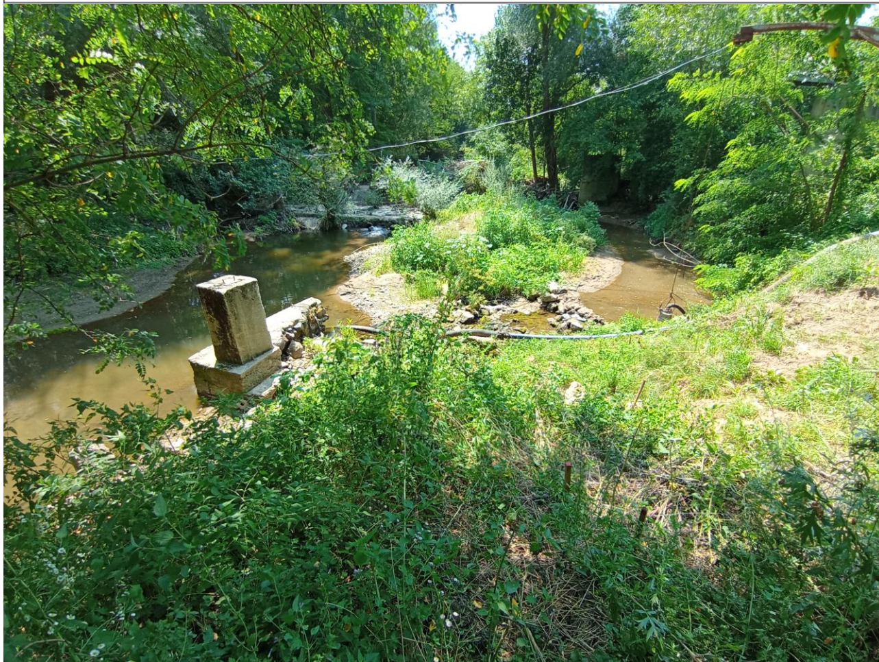
Slika 4. Mikro lokacija KP 3435 na kojoj se planira izgradnja vodozahvatne građevine sa taložnikom – izgled
