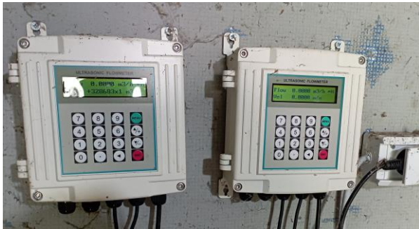
Slika 29. Merač protoka zahvaćene vode i objekat u kome se nalazi
